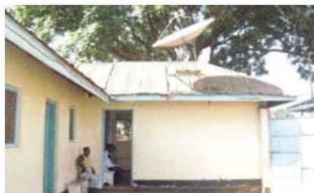
Majengo CHI Dispensary
